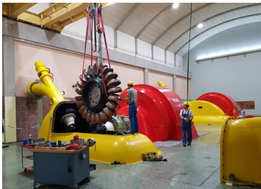
Montage de la roue de réserve du groupe 2 de Croix
